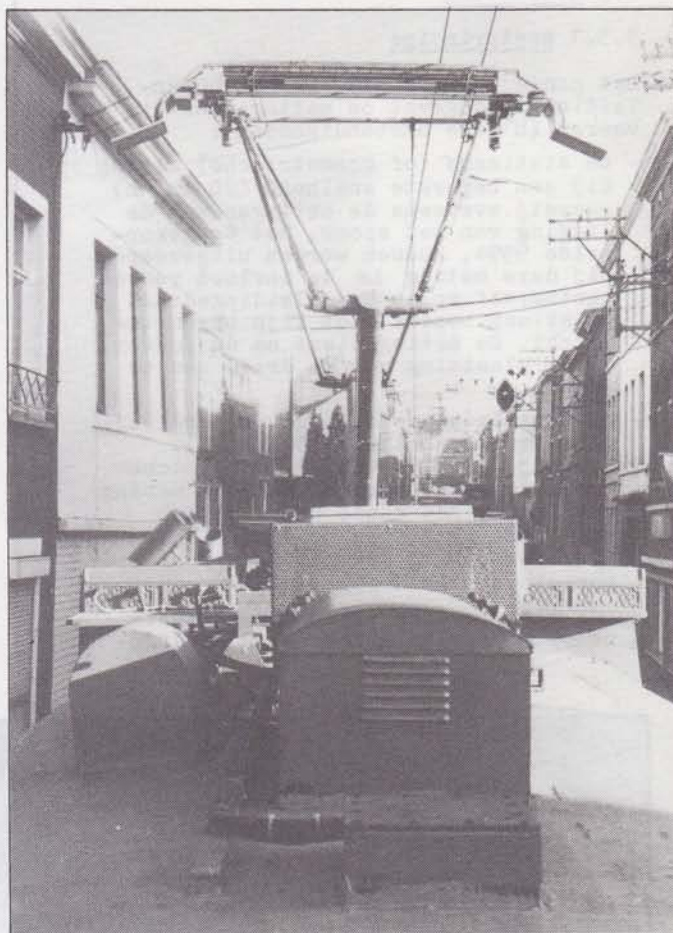
De speciaal aangepaste meetpantograaf van meetrijtuig 9591, zoals te zien vanuit de observatiepost tijdens een meetrit. Gosselies, Rue Emile Vandervelde, 12.84.
